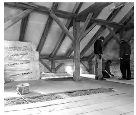
Beim Einbringen der Dachbodendämmung: Holzfasermatten
